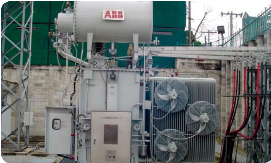
Transformador de Potencia de Subestación Cambray 15/22/28 MVA, con Regulación de Tensión Bajo Carga.
