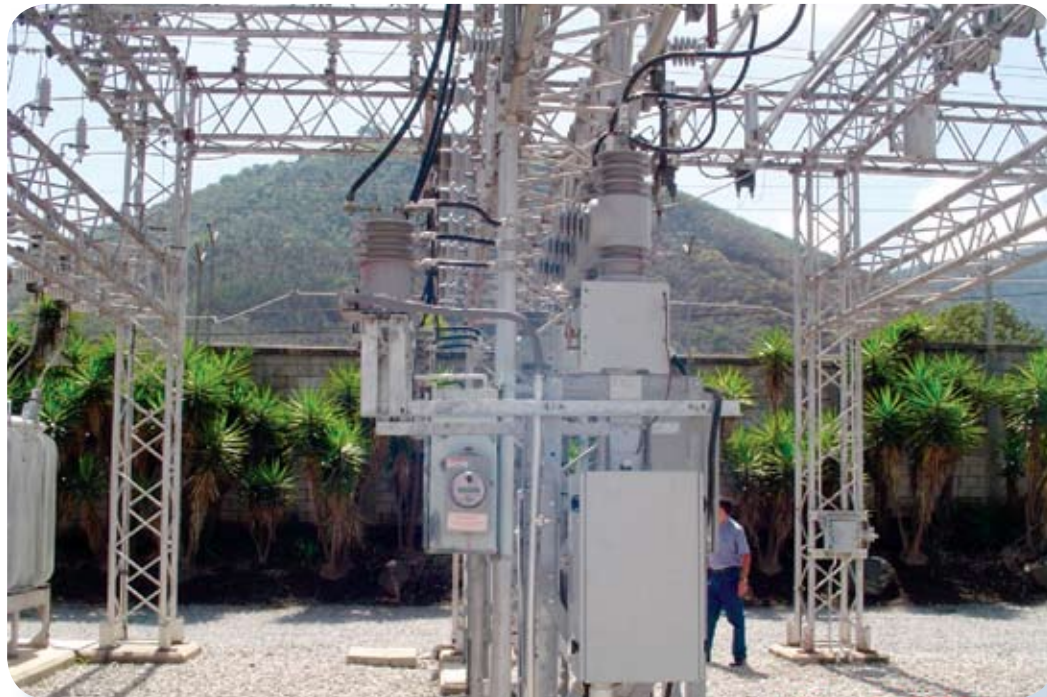
Salida de MT Nueva de 13.8 kV de Subestación San Gaspar, Tipo Convencional.
